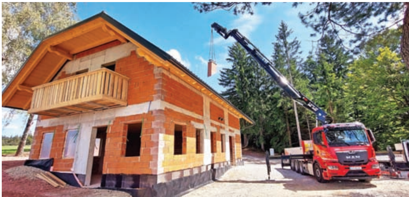
Gradnja Doma nad Zalo je tekla po načrtu. / Foto: Štefan Bogataj
